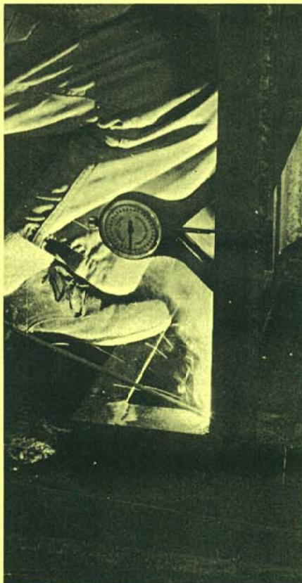
★ 形鋼の溶接作業に
